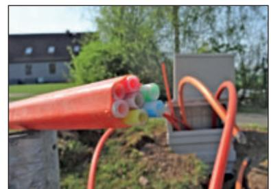
Leerrohrverbände die Glasfasern eingeblasen. Von den neuerrichteten Verteilern gehen dann sternförmig die Leitungen zu den jeweiligen Hausanschlüssen der einzelnen Grundstücke.
